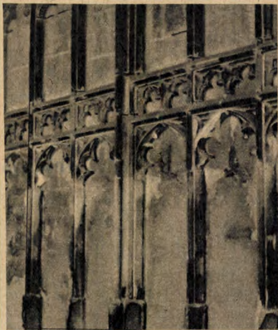
A Gloucesteri Katedrális fala. Az angol Rentokli Vállalat a magyar mérnökök eljárásával mentette meg a műemléket. Az elektromos rövidrezárással alkalmazása után 1 év alatt tökéletesen kiszáradt az épület
